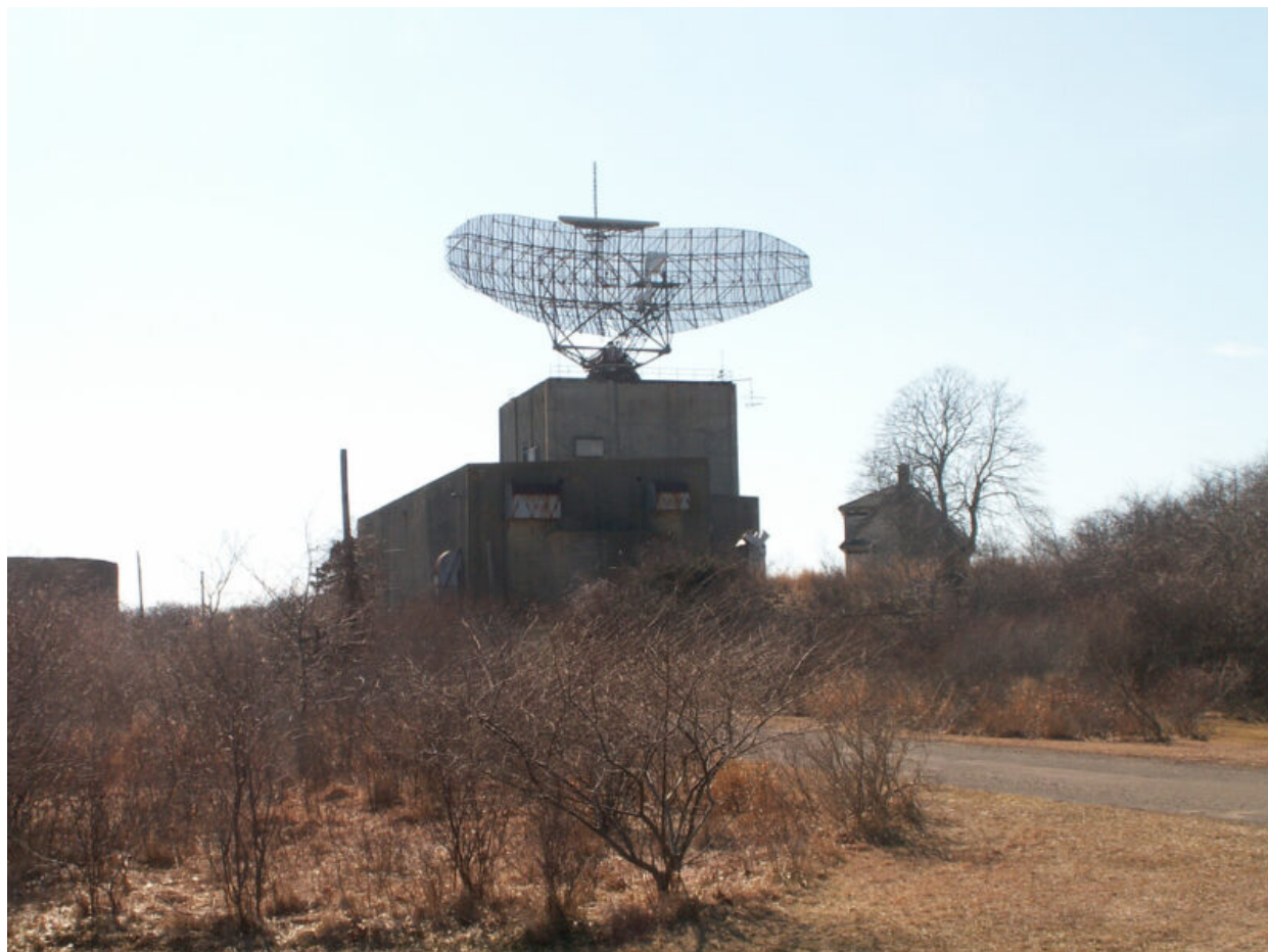
Die Ruine des riesigen Radars auf Camp Hero (Foto: Americasroof)
